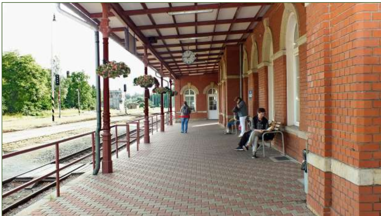
Zastřešené nástupiště železniční stanice Mimoň po rekonstrukci dlažby a střechy, která proběhla v roce 2008. Pohled ve směru staničení trati k Liberci.
