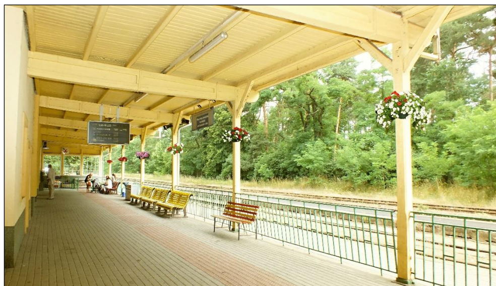
Nástupiště stanice Doksy při pohledu od nádražní restaurace k České Lípě
