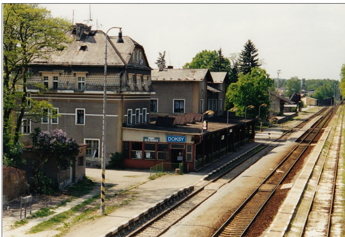
Budovy železniční stanice Doksy před rekonstrukcí, foto 2000 z nádražní lávky
