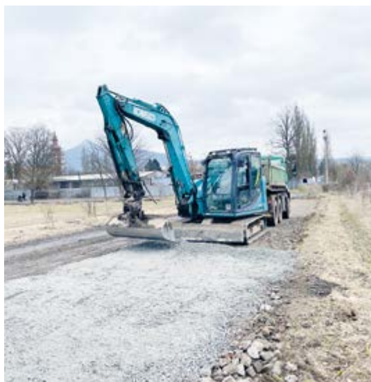
zpevňování komunikace u Hřebčína
